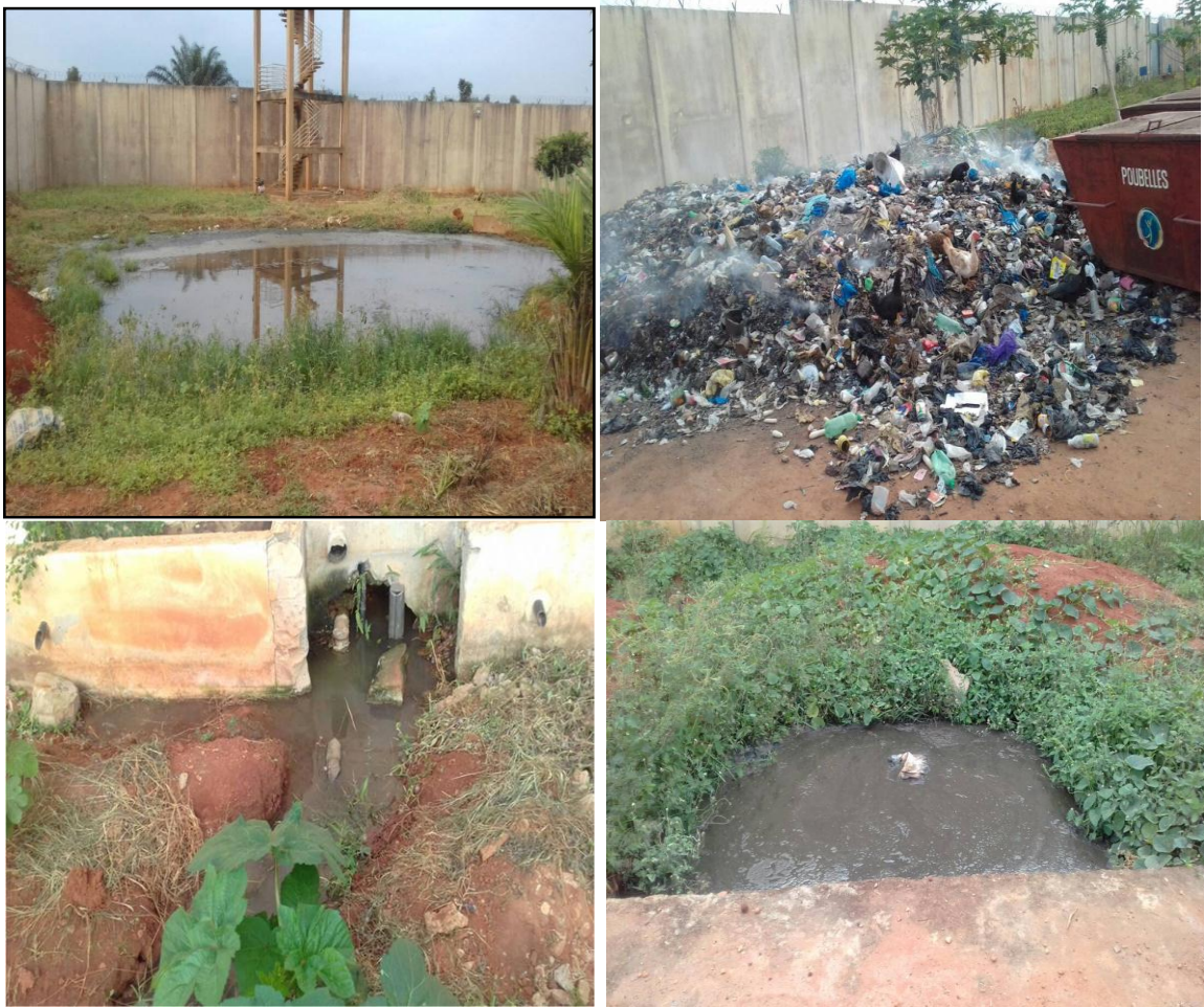
Figure 3: Vue sur la canalisation des eaux usées et la gestion des ordures à la prison civile d'Abomey -Calavi
